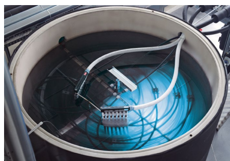
Blick in das Innere des „Vitifriocal“-Eisspeichers
